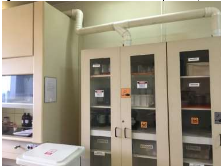
Figura 8 e 9 – Armário de armazenamento dos produtos químicos
